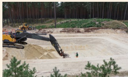
In großen Waldgebieten müssen künstliche Löschwasservorräte geschaffen werden. Hier beginnt mit dem Aushub das Anlegen eines Folienteiches.
