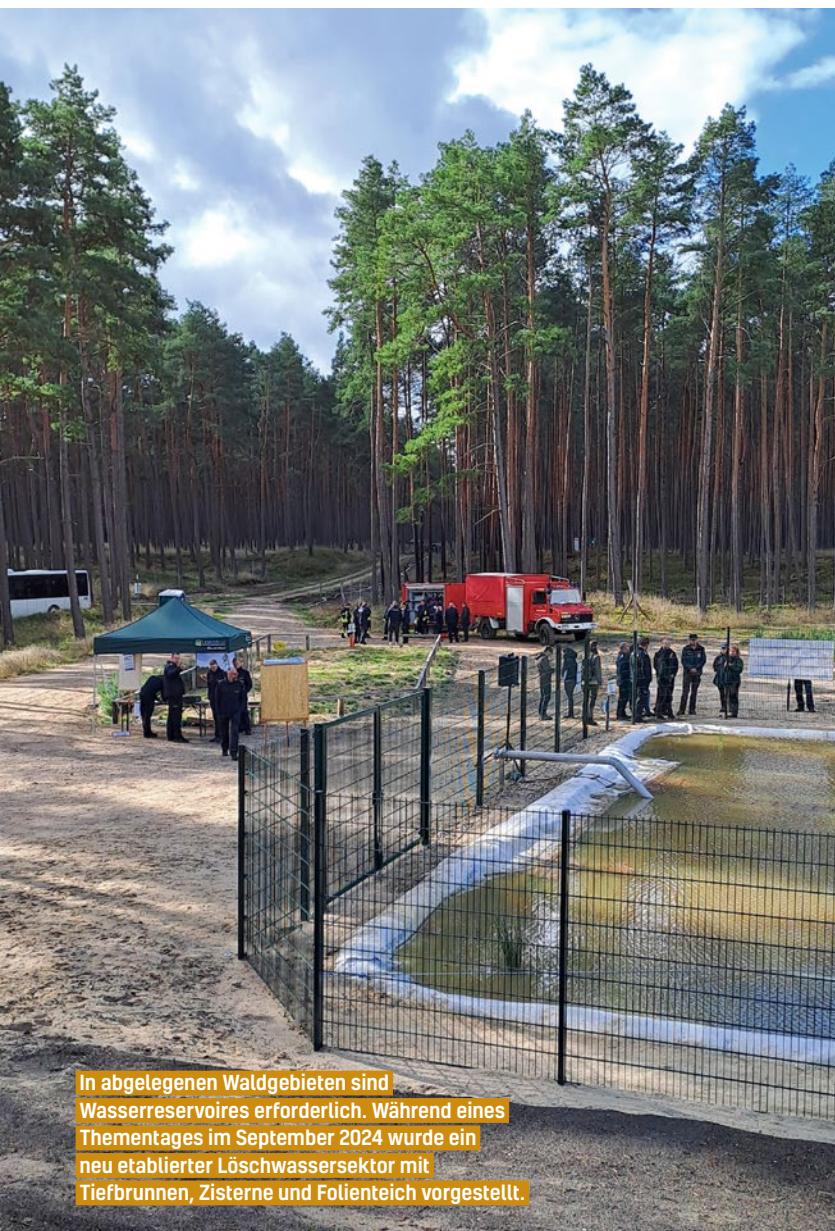
Der Anschluss für den Löschwasserfolienteich mit solarbetriebener Unterwasserpumpe.
